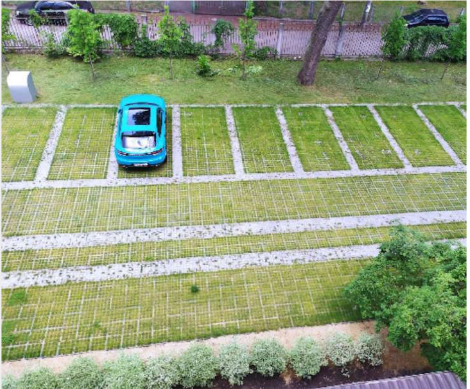
Рисунок 66: Паркування, облаштоване покриттям, що дозволяє стік дощової води до ґрунту (т.з. «Зелене» паркування), готель, Київ
